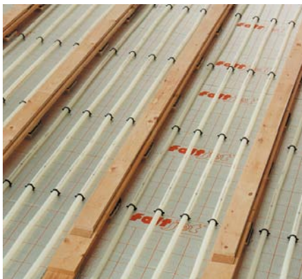
pose des tuyaux de chauffage Radson Difustop® dans la cavité.
