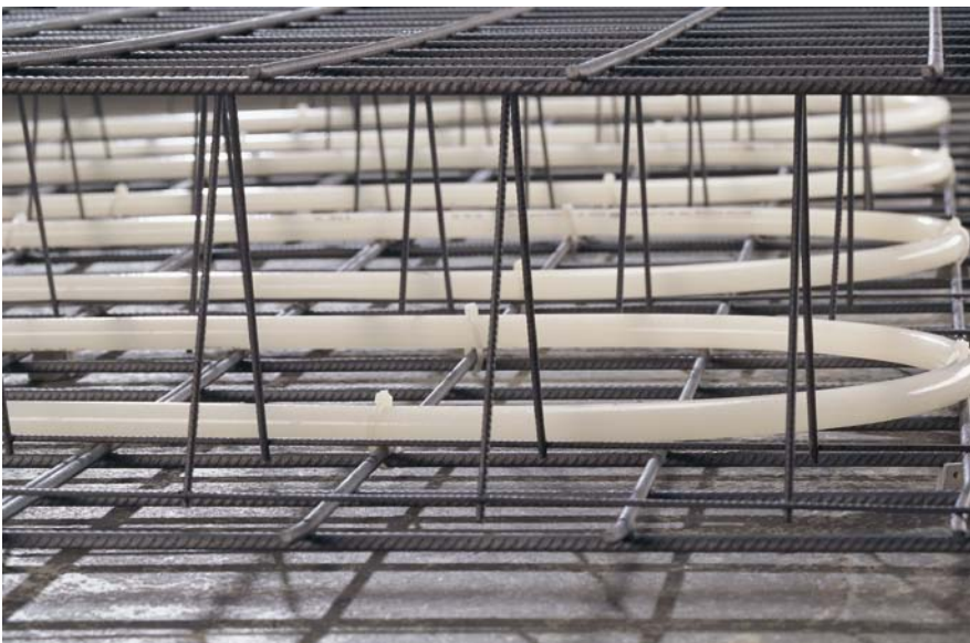
le tuyau Difustop repose bien à l'abri sur l'armature inférieure
