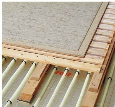
pose du support, du panneau aggloméré et de la couche supérieure.
