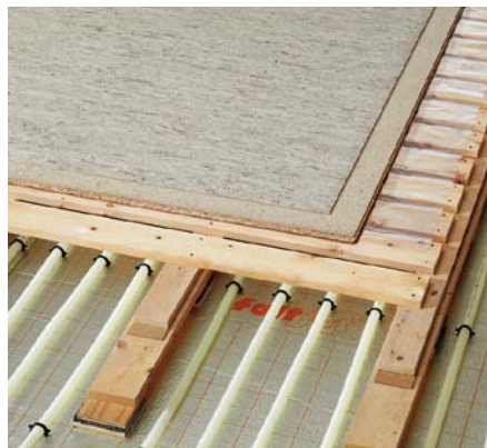
onderlaag, spaanplaat en toplaag aanbrengen
