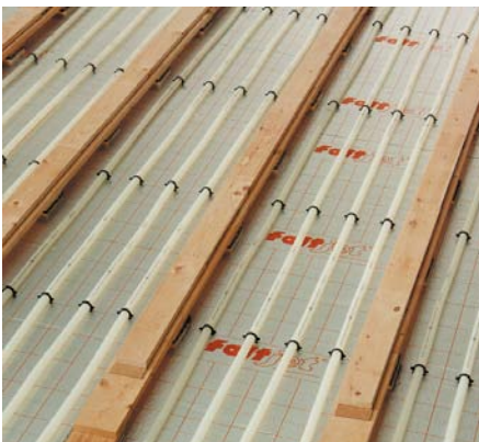
Radson Difustop® verwarmingsbuis aanbrengen in de tussenruimte
